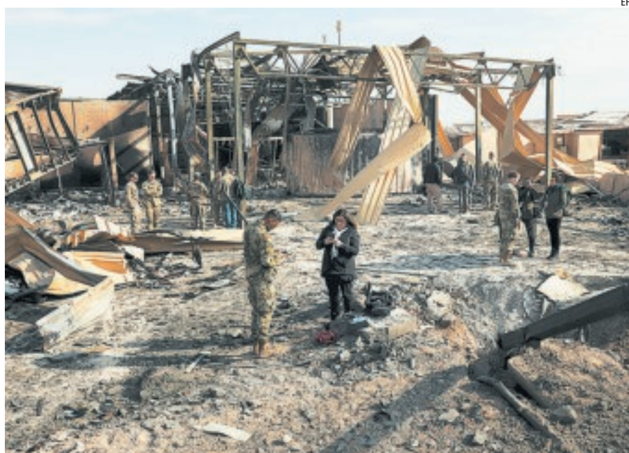
Soldados de EE UU evalúan los daños sufridos en la base Al Asad de Irak
